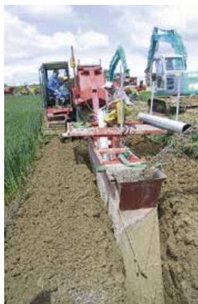
2 Bilancio idrico del terreno: la tecnica attuale consente di realizzare costruzioni veloci e compatte del tipo «tutto in uno». Qui un collettore viene posato con una «fresatrice a montante mobile».
