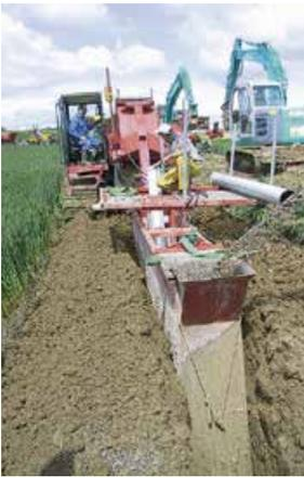
**2** Régime hydrique du sol: les techniques actuelles permettent de réaliser des constructions compactes et rapides «tout en un». Un collecteur est ici posé avec «une trancheuse à étaillage glissant»
