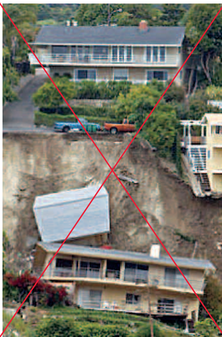
Fig. 2: Glissement de terrain typique
